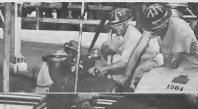
E TRABAO di reparacion ta consisti di trabaoonan grandi y chikito. Un derrick ta worde usá pa pone un di e sustantan di p'abao pa e cilindronan reaccionador, banda robes, den posicion. E parti p'abao di e chamber, cu ta mas hancho na su rand, ta worde poni den posicion.
